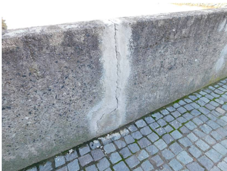
Sanovaná trhlina v zábradelní části čelní zdi
