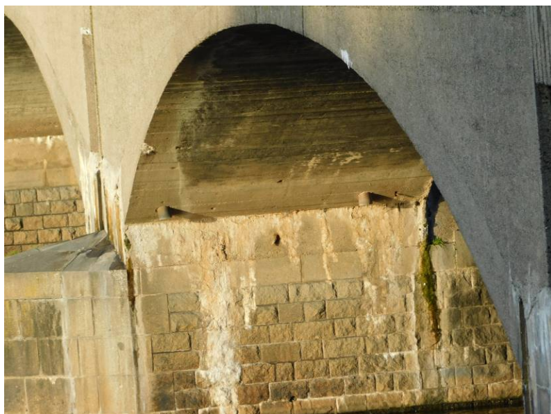
Průsaky v patní části oblouků v poli 3
