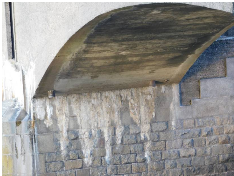
Průsaky v patní části oblouků v poli 2
