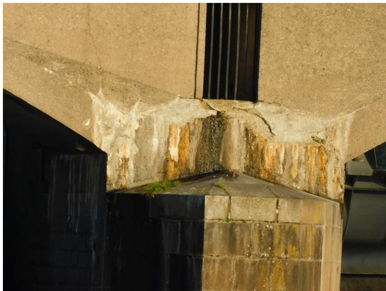
Typické průsaky na středních pilířích v úrovni patních částí oblouků
