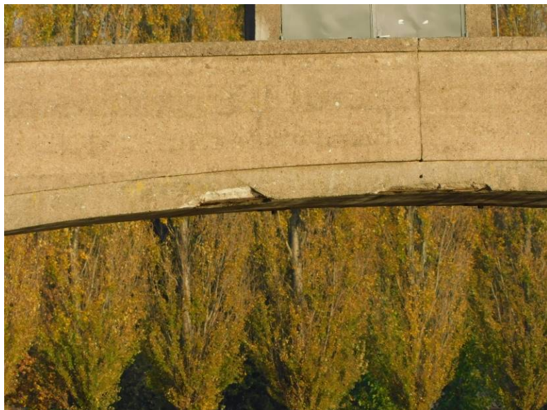
Separace krycí vrstvy a obnažená výztuž oblouků
