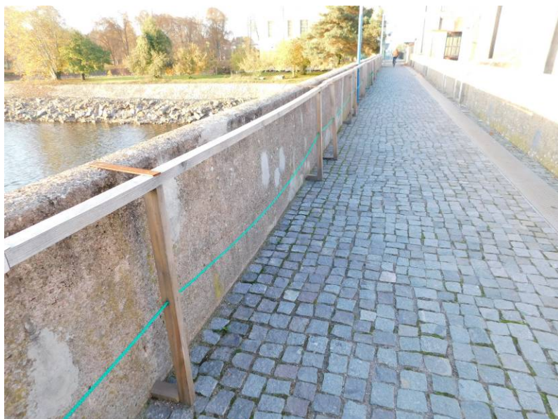
Provizorní zábrana na mostním svršku
